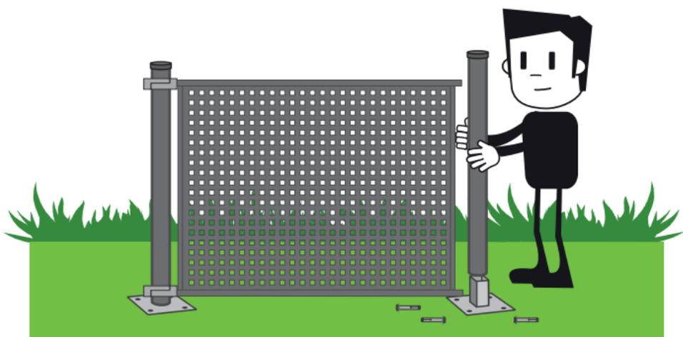
8. Instalar el accesorio comodín al bastidor y atornillar el conjunto a la abrazadera del poste
